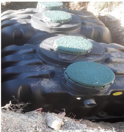
Afin de remplacer la pompe de relevage qui a cassé pour la seconde fois, et suite aux conseils de M. Tardieu (technicien SPANC) nous avons réalisé en régie un assainissement individuel pour le garage communal.
