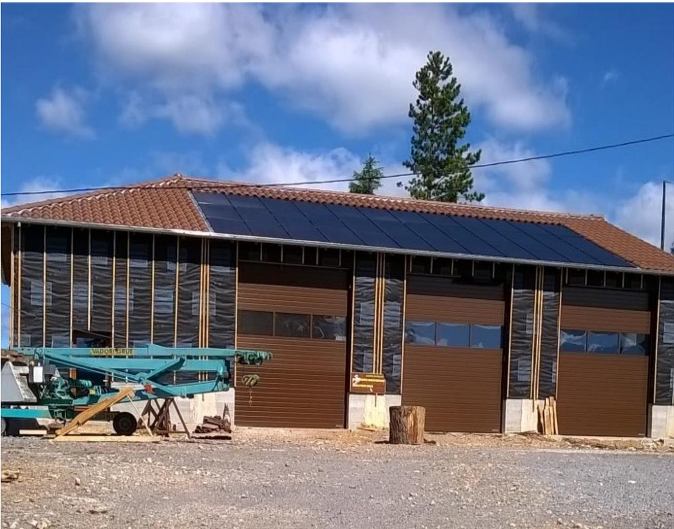
Le toit est terminé, des panneaux photovoltaïques ont été installés, les volets roulants posés.
